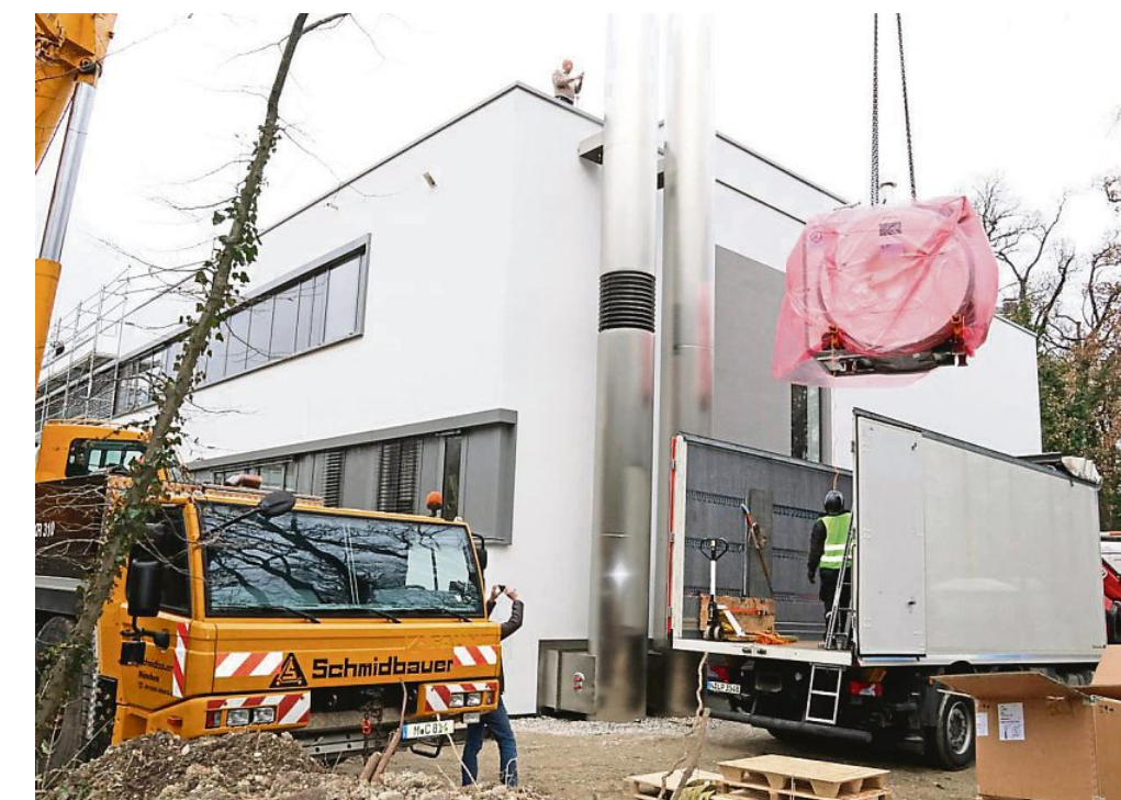
Neueste Technik im Anflug: Aufgrund einer Kooperation bietet die Klinik eine Radiologie im Haus an. Hier hebt ein Kran das neue MRT-Gerät durch die Decke in die Klinik. FOTO: DR
